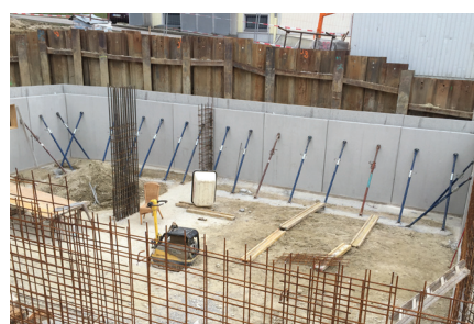
BTS M: šikmé pilíře / lešení
